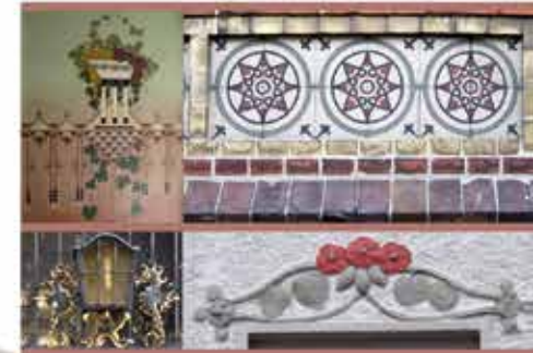
Gestaltungselemente um 1900: Villa Hildebus, Leeuener Straße: Schablonenmalerei im Innenbereich, um 1905. Mothaus Douwesstraße: geometrische Muster aus Mosaiksteinen und Ziegelsezierungen, um 1904. Wasser- und Schiffahrtsamt, Friedrich-Naumann-Straße: Schwiedearbeit mit Laterne, Seepferd und Seeotter, um 1900. Villa Anna, Rüssel-Deutscher-Straße: Gipsdarstellung in Putztechnik, Jugendstil, um 1910.
