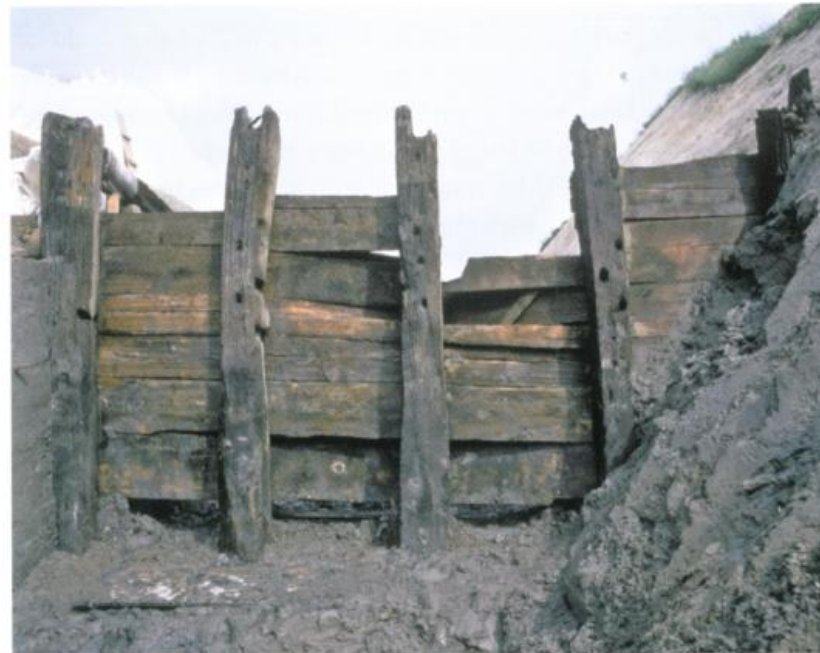
Abb. 103. Frontansicht des Stackdeiches am Adolfskoog, Eiderstedt; errichtet 1604 aus Eichenpfählen, die mit Fichtenplanken verbunden sind. Foto H.J. Kühn, ALSH Schleswig
