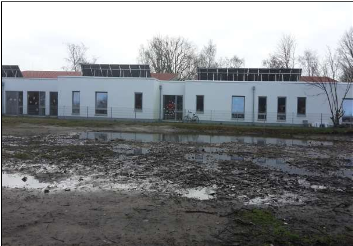
Abb. 2: Vorne: Lage der ehemaligen Kindertagesstätte; Hinten: Neubau Kindertagesstätte
