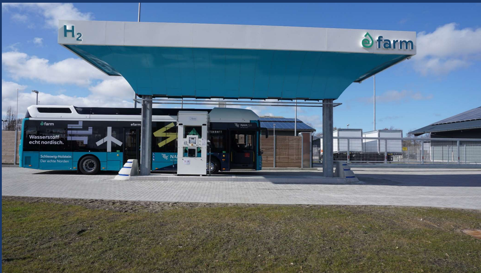
Wasserstofftankstelle in Niebüll, Nordfriesland
