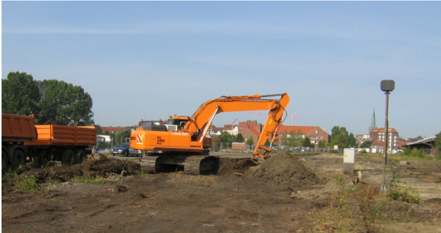
Bodenaustausch im Bereich des Bebauungsplanes D 146 Teil 1
